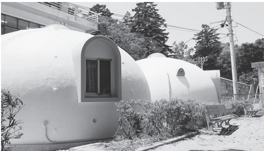
ドームハウスの眼科仮診療室
